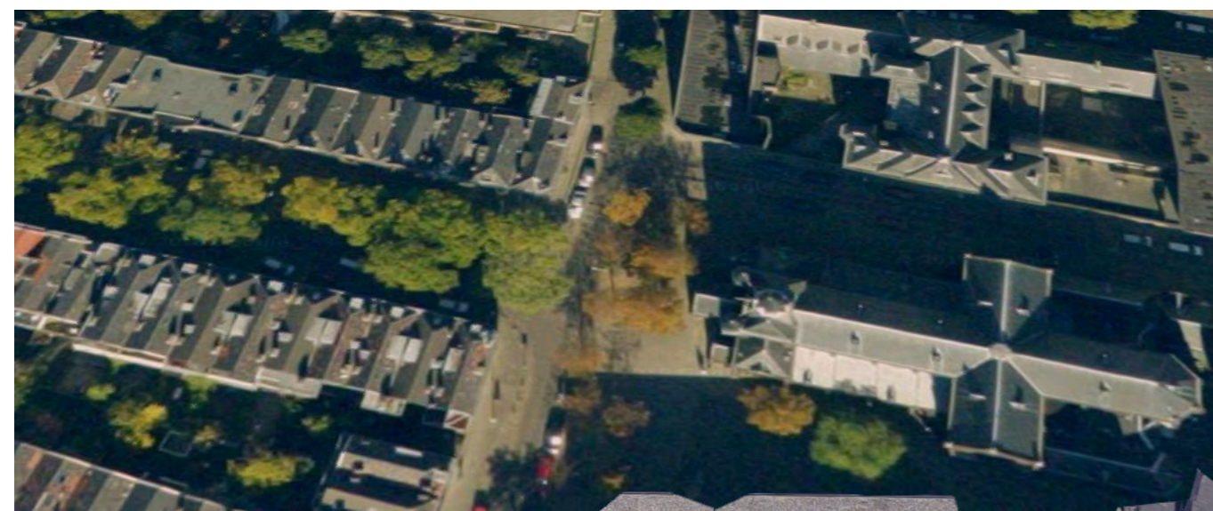
Afbeelding 3.1: Het Hildegardiskerkplein van bovenaf gezien. Opmerking: Overgenomen van Google Maps.
